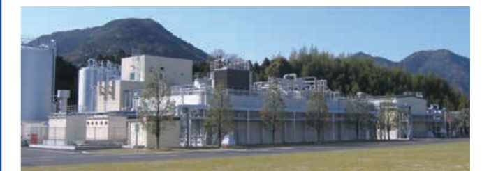
拝田グリーンバイオ事業所メタン発酵設備全景
