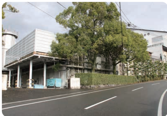
本社工場排水施設
