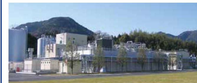
拜田グリーンバイオ事業所メタン発酵設備全景
