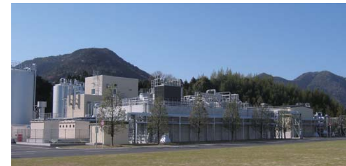
拜田グリーンバイオ事業所メタン発酵設備全景
