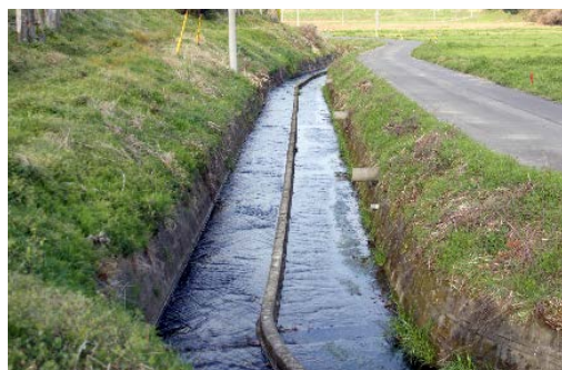
工場排水（左）と上流からの流れ（右）が確認できるよう仕切りを設置した山本幹線排水路
